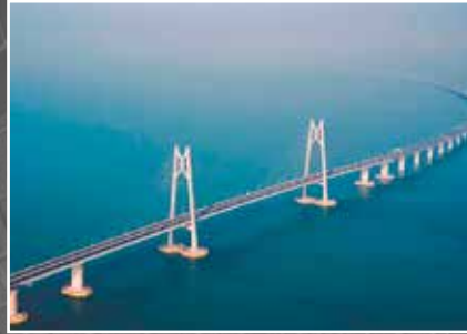
Puente y túnel de 55 km con una anchura de 6 carriles.
